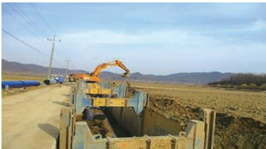
송수구간 관로매설 전경
