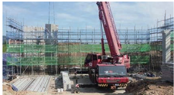
양수장 시공 전경
