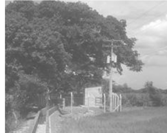
사진 7. 6호 관정 시공
