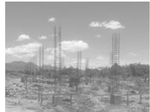
사진 14. 건축 기초 타설
