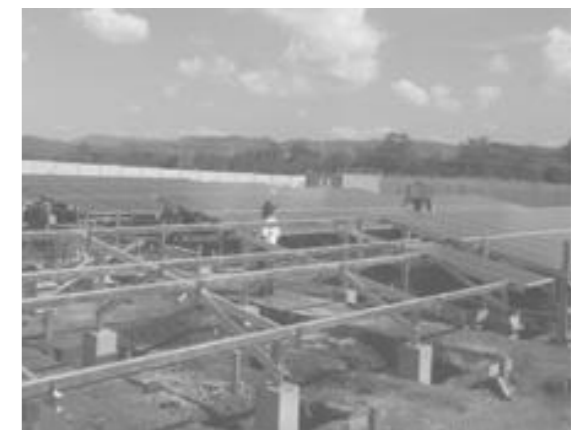
사진 9. 태양광 패널 설치
