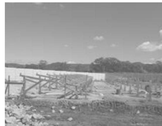
사진 8. 태양광 패널 지지대 설치
