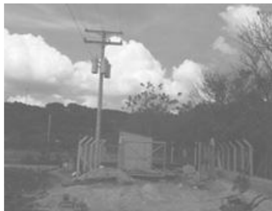
사진 13. 7호 관정 변압기 설치 완료
