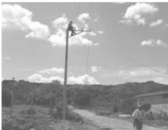
사진 12. 전기 전신주 부속 자재 설치
