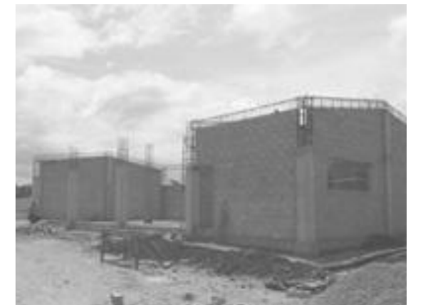
사진 15. 벽체 블록쌓기 완료
