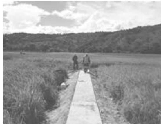
사진 1. 수로 기초 콘크리트 설치
