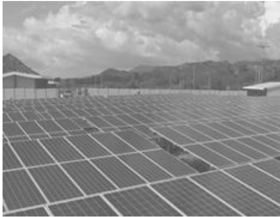
사진 10. 패널 설치 완료
