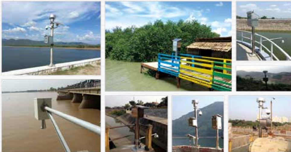
그림 17 | 태국, 베트남, 미얀마, 이란, 파키스탄 현장설치 사진
