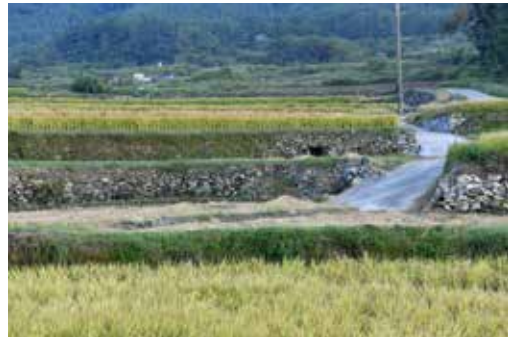
그림 4 | 구들장논 연속관개시스템
